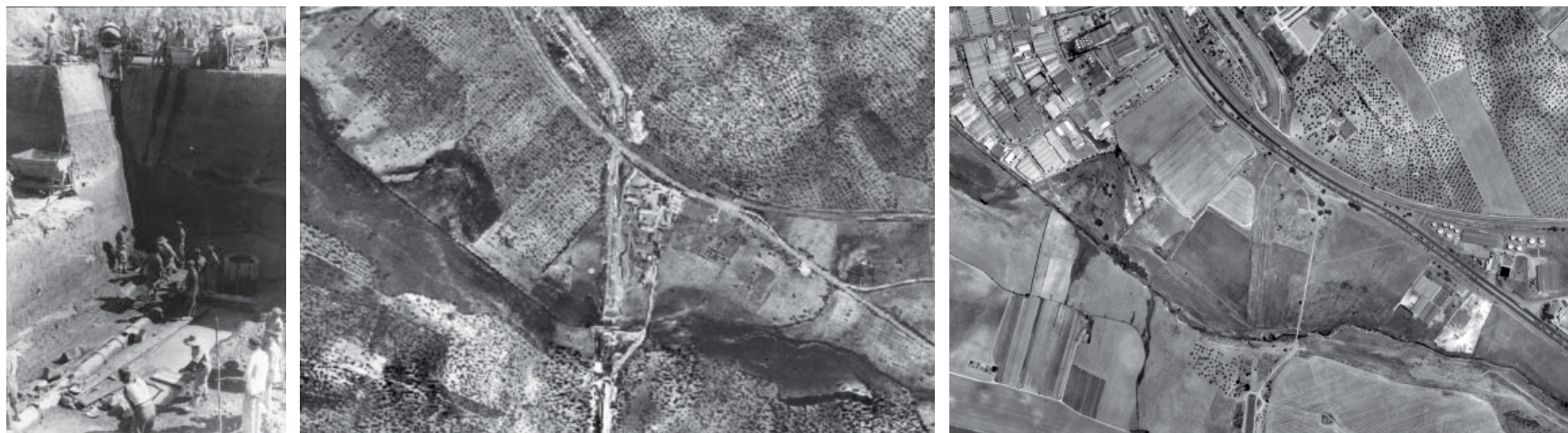
Trabajos de construcción del Canal. / Foto: ECP/CHG. Gonzalo Acosta. RMHSA. Vista del Campo de Los Merinales en el “vuelo americano” 1956 y en la actualidad.
