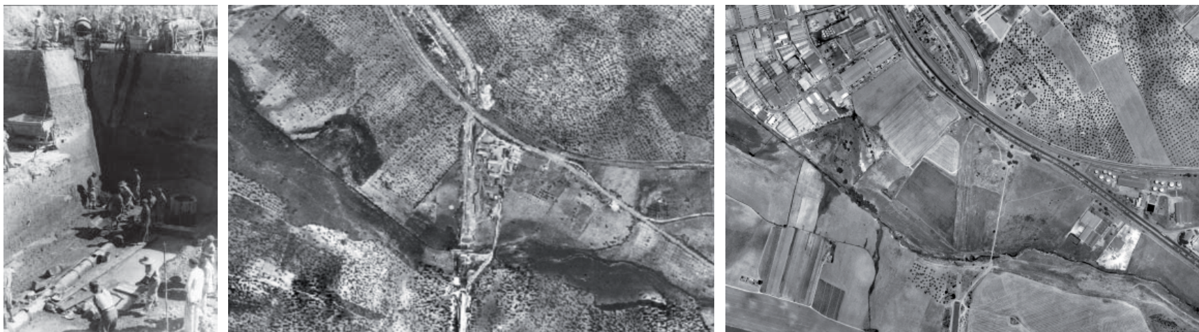
Trabajos de construcción del Canal. / Foto: ECP/CHG. Gonzalo Acosta. RMHSA. Vista del Campo de Los Merinales en el “vuelo americano” 1956 y en la actualidad.
