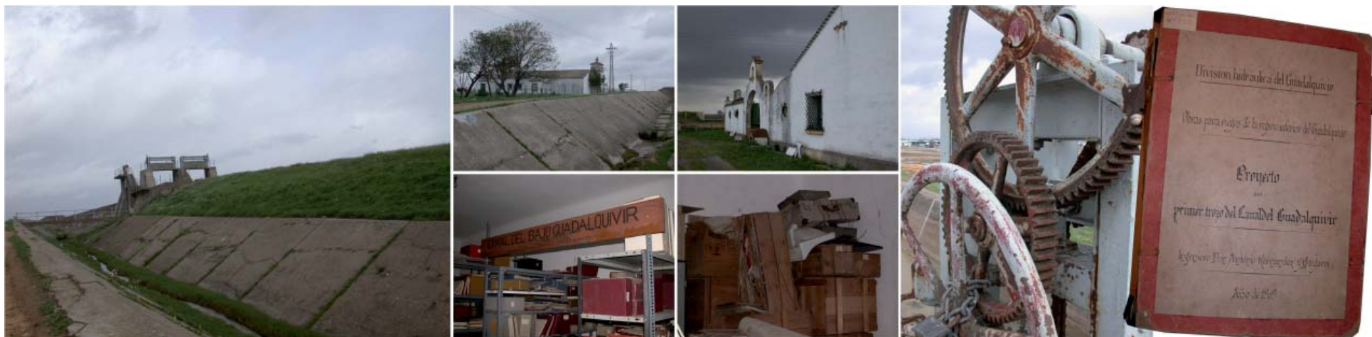
Instalaciones y documentación de la CHG . Km-78 del Canal, previo al sifón del Guadaíra./ Fotos: jva
