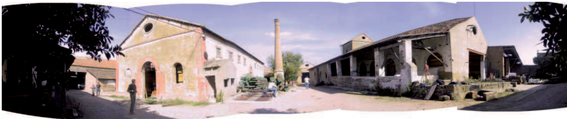
Panorámica interior del recinto de las bodegas desde la zona de oficinas. DFAP
