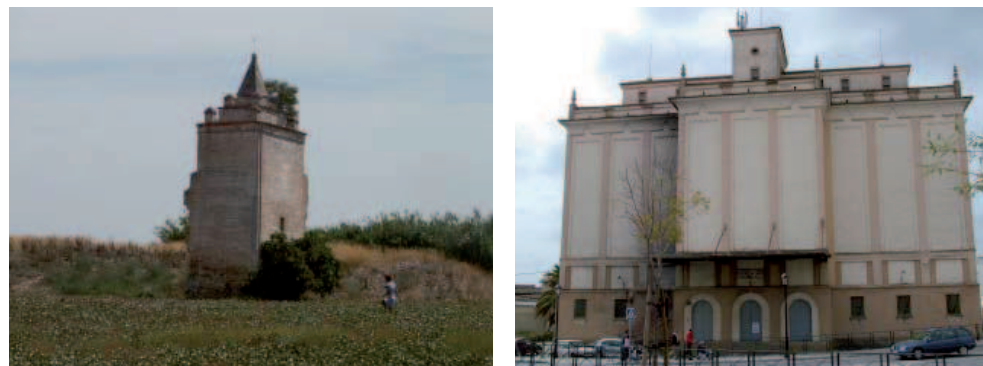
Torre contrapeso de antiguo molino de viga. Fachada principal del silo de Carmona / MBT-MSF
